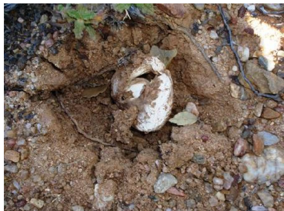
Rompimento do chapéu
